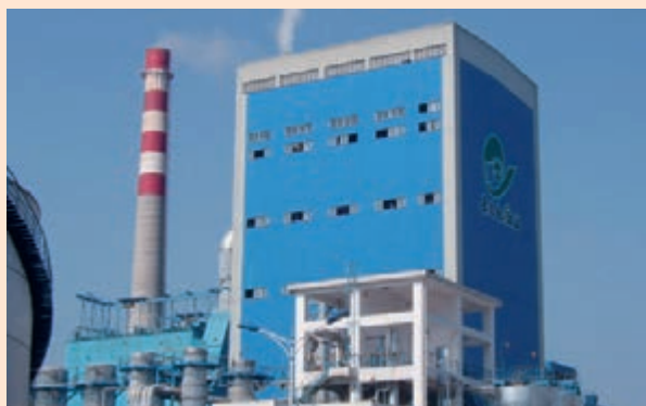
贵州赤天化纸业 1500 tds/d 竹浆 碱回收锅炉燃烧工段总成套
