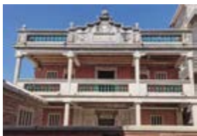
图 1.1 泉州永宁迳春晖楼
