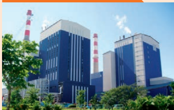
海南金海浆纸 2200 tds/d 木浆 碱回收锅炉燃烧工段总承包
