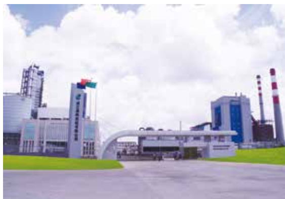
湛江晨鸣纸业集团有限公司漂白木浆项目
