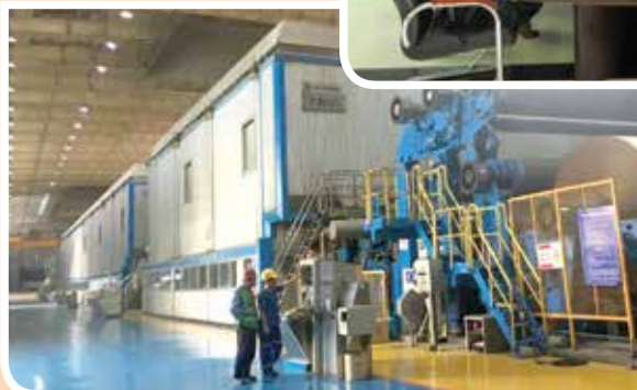
公司技术人员在纸厂进行现场服务
