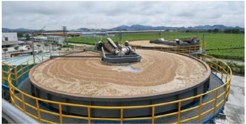
艺：好氧→二次沉淀→气浮深度处理，其岳阳、沅江、永州、怀化等基地 $20\ \text{万}\ \text{m}^3/\text{d}$ 处理量的废水也全部使用新一代CQJ型超效浅层离子气浮净化器，二沉池出水 $\text{COD}_{\text{Cr}} < 270\ \text{mg/L}$ ；气浮出水 $\text{COD}_{\text{Cr}} < 50\ \text{mg/L}$ 。
